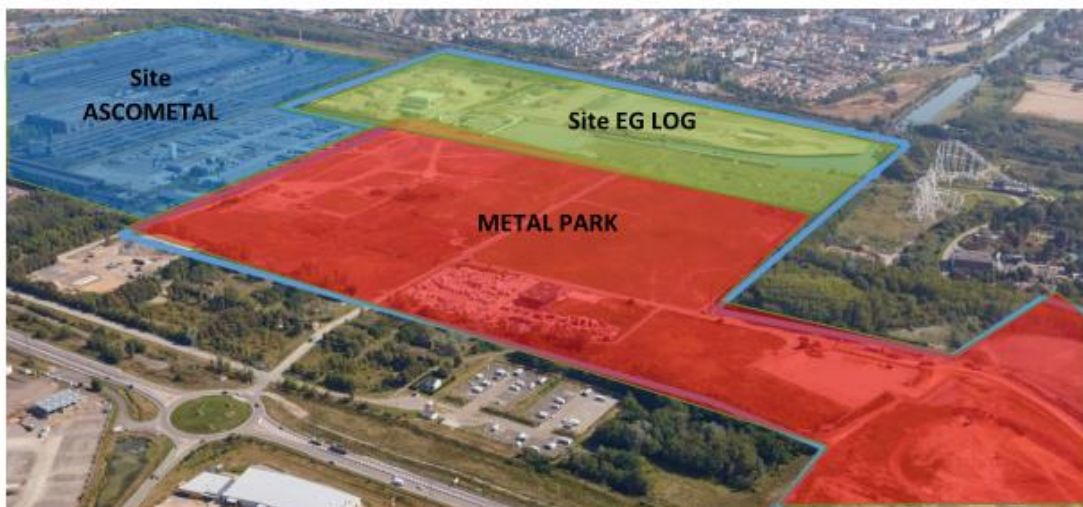
Voisinage du projet METAL PARK® sur la Zone Industrielle du Port
